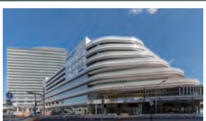
2021 ブランズタワー大船/グランシップ 約1.7haの敷地を有する タワーマンションと商業施設の 大船駅前複合再開発
